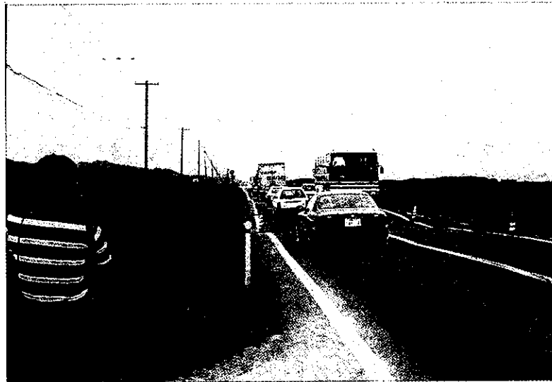
図5-2-19 波打ったようになった国道5号線（長万部町豊津衛生処理場付近）
