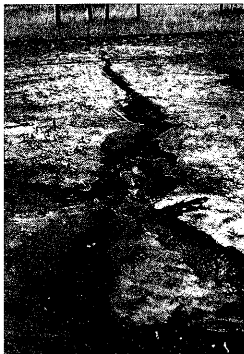
図5-1-4 液状化によって生じた噴砂・亀裂（乙部町）
