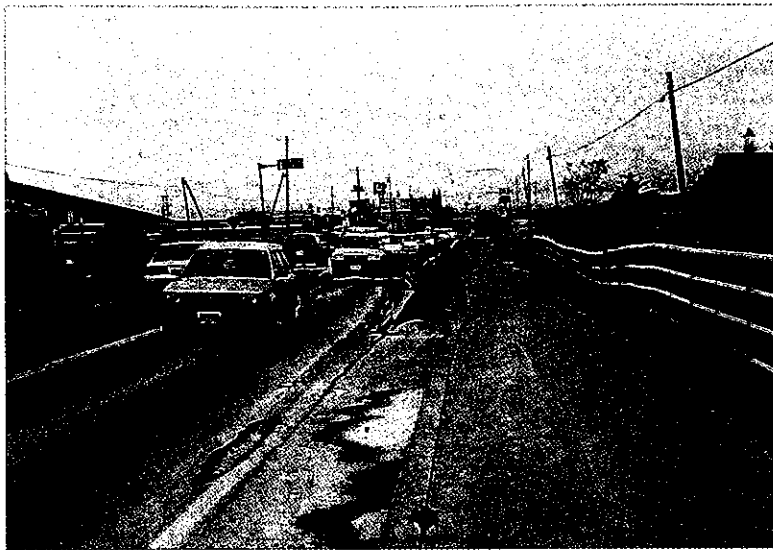
図5-2-13 波打ったようになった国道5号線と路肩の崩壊（長万部町立中の沢小学校付近）
