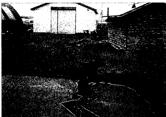
図5-1-3 液状化によって生じた亀裂（江差町）
