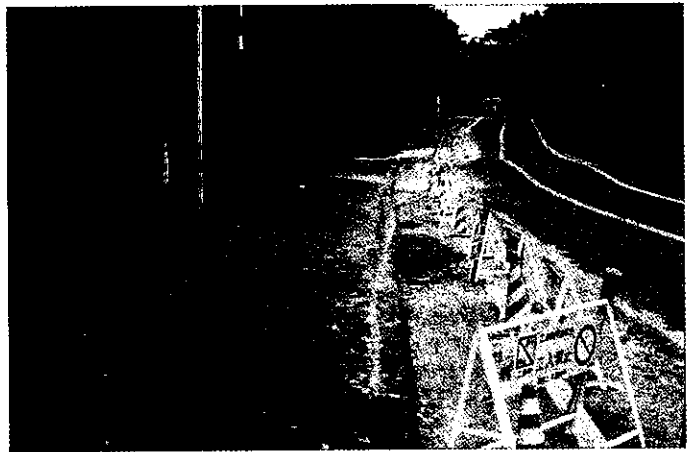
図5-1-6 大沼湖岸で認められた沈下(七飯町)
