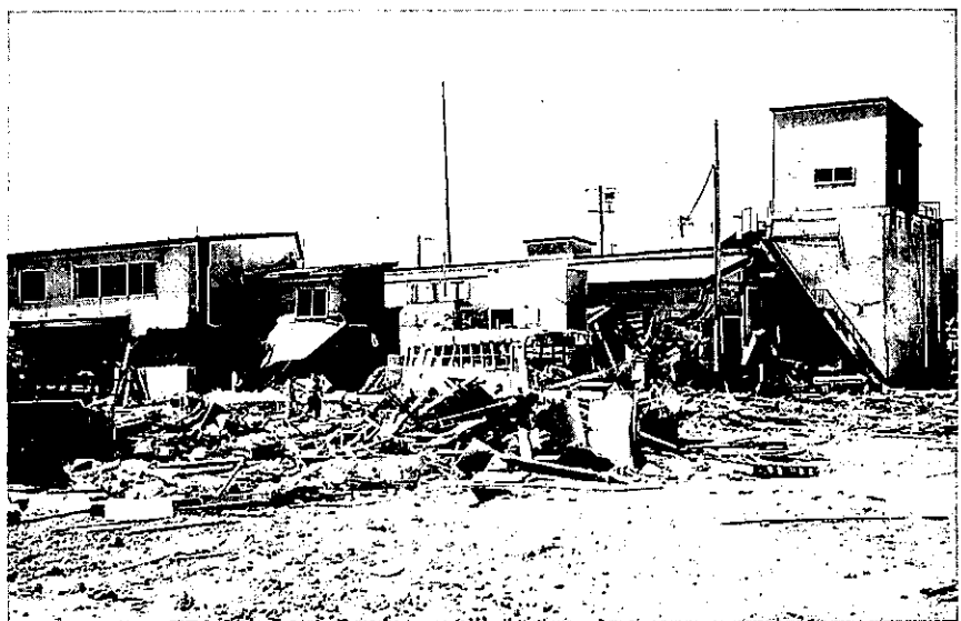
奥尻漁業協同組合荷捌所
