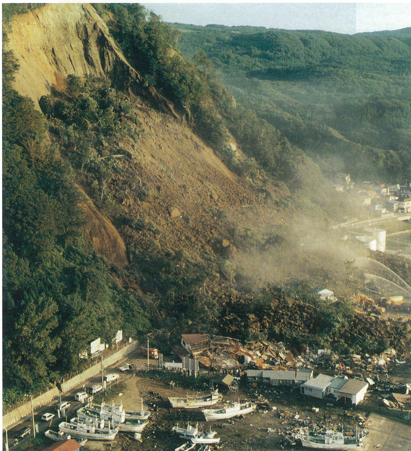
奥尻町奥尻地区の土砂崩れ〔北海道新聞社提供〕
