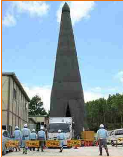
ボーリング調査 (HDB-11孔)
