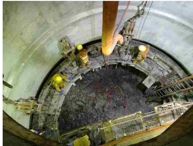
東立坑 (平成26年3月26日撮影)
