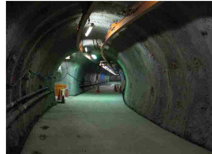
深度350m調査坑道 (平成26年2月25日撮影)
