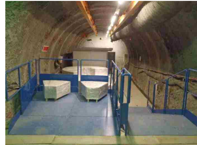
深度350m調査坑道 試験坑道4 人工バリア性能確認試験実施箇所 (平成27年1月13日撮影)
