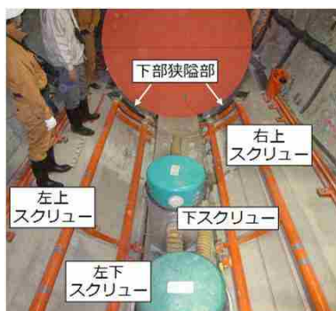
スクリー方式による埋め戻し材の施工
