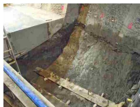
切り欠きの掘削とプラグの施工例
