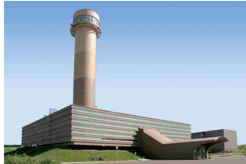
「ゆめ地創館」(平成19年6月30日開館) 地下深部での研究内容を紹介 * 地下施設の工事状況等をリアルタイムでご覧いただけます。
