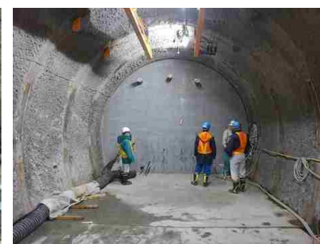
切り欠きの掘削とプラグの施工例
