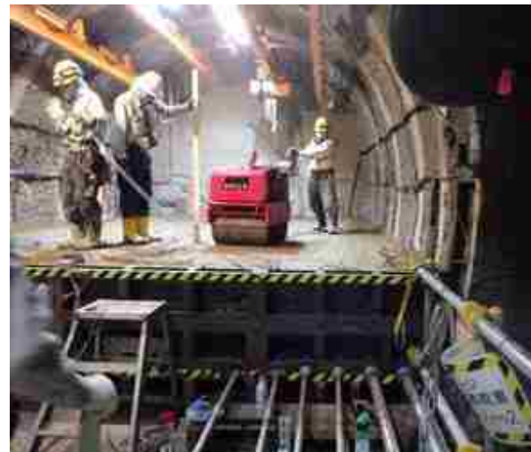
埋め戻し材の施工(左:転圧締固め、右:ブロック積み上げ) 10
