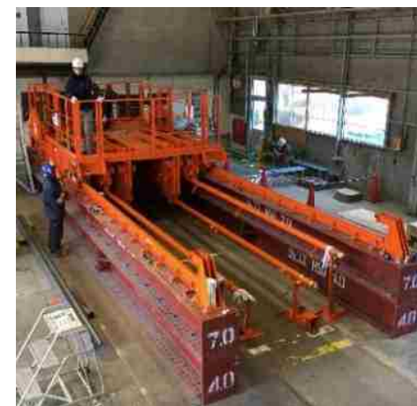
スクリー方式による埋め戻し材の施工 16
