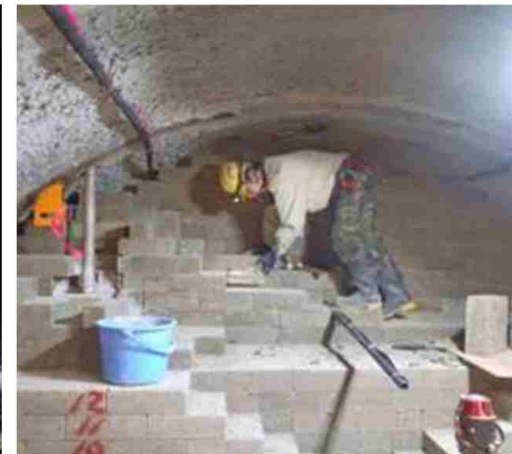
埋め戻し材の施工(左:転圧締固め、右:ブロック積み上げ) 10
