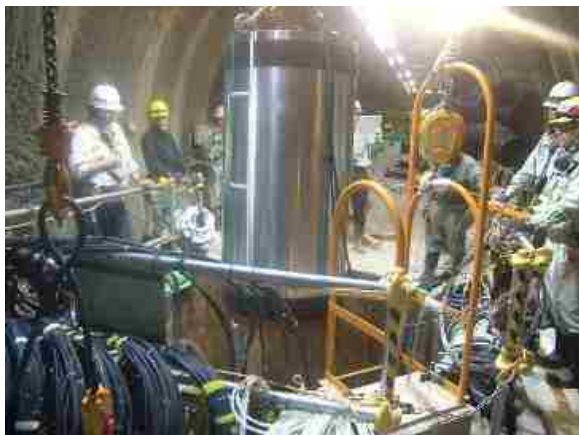
人工バリア性能確認試験 (オーバーパックの設置)
