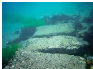
写真4 海中に設置したコンクリート板の様子
