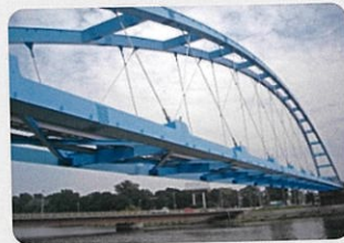
伏籠川水管橋
