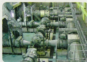
鷺別ポンプ場
