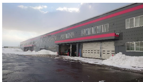
石狩物流センター
