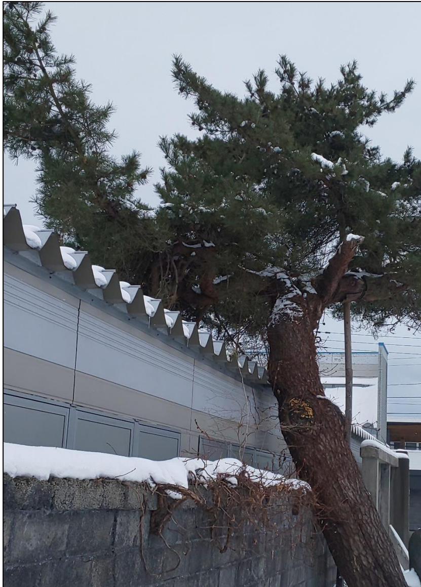
③ 敷地内（南側）から樹木傾斜状況
