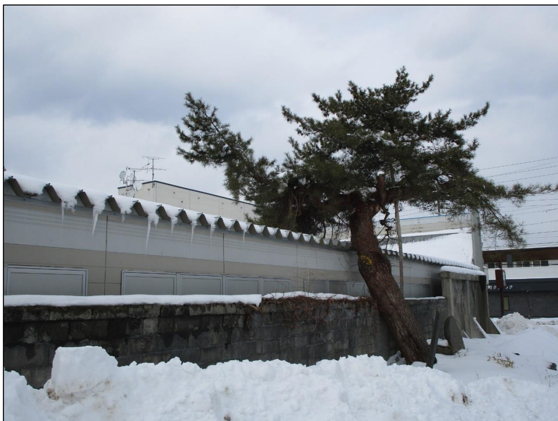
② 敷地内（南東側）から樹木傾斜状況
