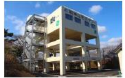
【津波避難タワー】
