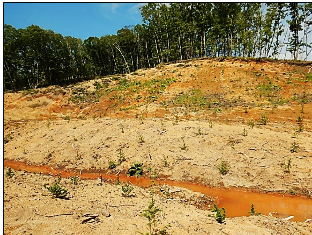
【復旧後】 R4年6月
