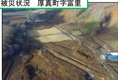
被災状況 厚真町字富里
