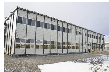
早来中学校仮設校舎(安平町)
