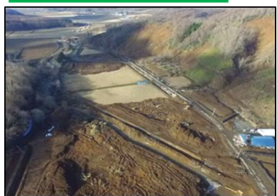
被災状況 厚真町字富里
