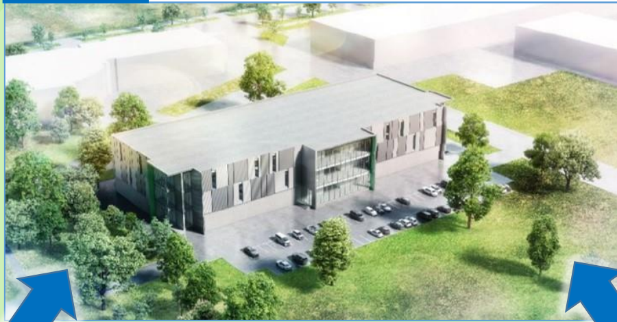
出典：石狩再エネデータセンター第1号 北海道電力HP
