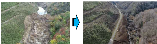
林道の復旧（厚真町 幌内宇隆線）
