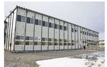
早来中学校仮設校舎(安平町)
