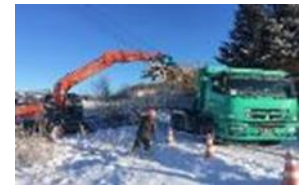
用水路の復旧工事に着手(厚真町)
