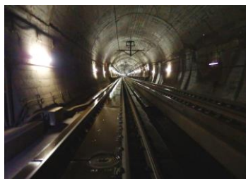
青函トンネル (三線式軌道)
