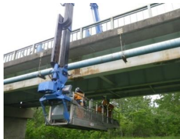
橋梁点検状況
