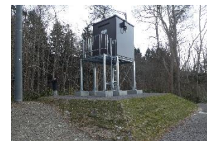
新中野ダム警報局更新（函館市）
