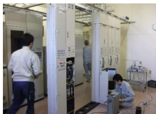
通信機器の点検作業
