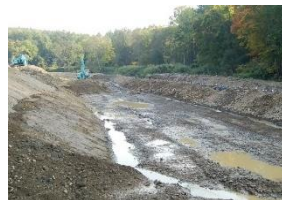
河道掘削状況
