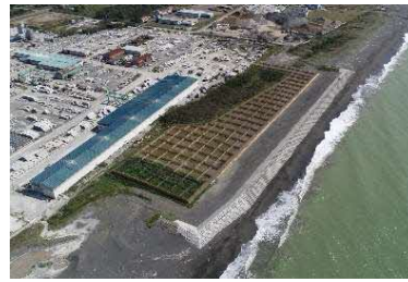
海岸防災林造成 (むかわ町)
