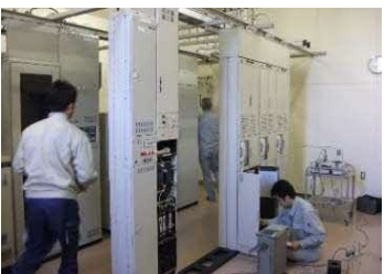
通信機器の点検作業
