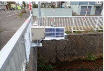
危機管理型水位計 (洪水時に特化した低コスト水位計)
