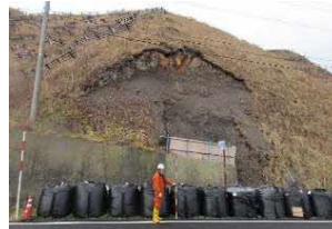
道路法面对策箇所
