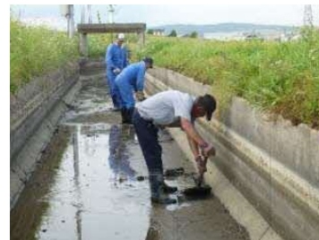
水路の泥上げ
