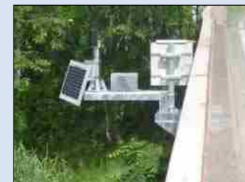
危機管理型水位計 (洪水時に特化した低コスト水位計)
