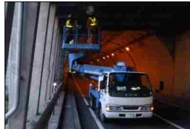
シエッド点検の作業状況
