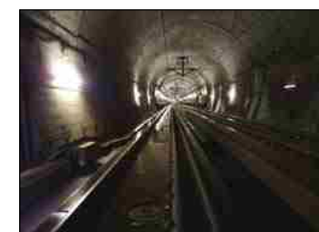
青函トンネル (三線式軌道)
