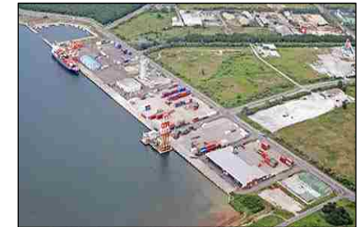
海上輸送拠点(石狩湾新港)
