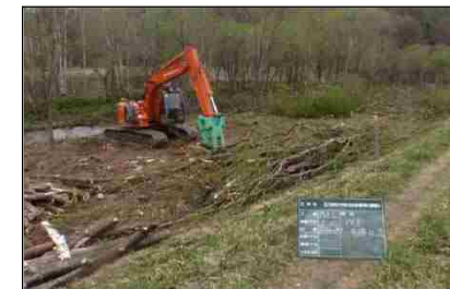
河道内樹木の伐採
