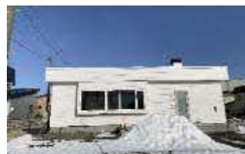
空き家対策事業による改修物件の様子
