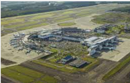
道内7空港一括民間委託により、本道の航空ネットワークの充実強化、広域観光の振興を図る。
