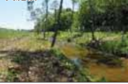
河川の掘削、樹木伐採（前・後）
