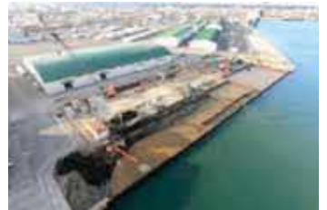
苫小牧港南ふ頭岸壁整備状況
