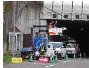
道路設備点検
