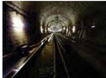
青函トンネル (三線式軌道)
