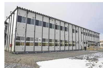
早来中学校仮設校舎(安平町)
