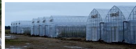
復旧した鉄骨ハウス（むかわ町）
