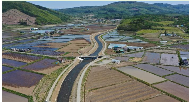
洪水から家屋や農地を守るため、河道掘削や堤防などの整備を行う。
