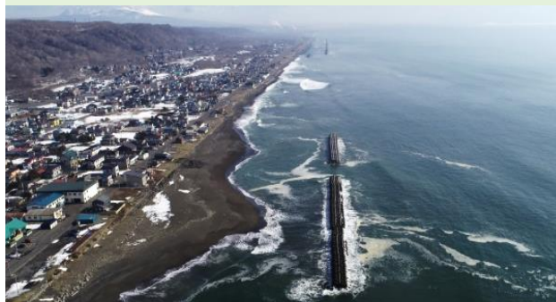
高潮・津波・砂浜の侵食から生命財産を守るため、海岸保全施設の整備を行う。
