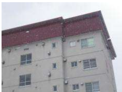
置屋根の屋根改修で軒を設けた例
