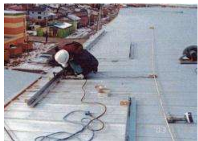
緩勾配屋根の雪止め金具の設置例
