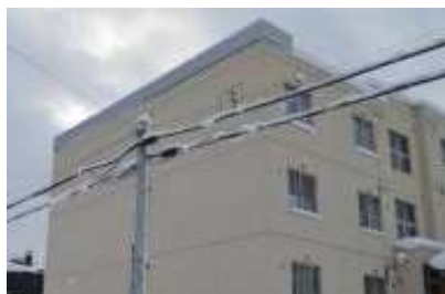
道営旭川市春光台団地
