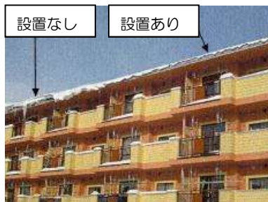
設置後の状況
