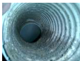
→ ダクト内清掃・ 抵抗大の部材や破損部材の交換
