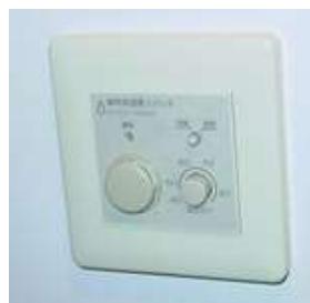
湿度感知センサー付き自動スイッチの設定湿度が高く常時停止していた
