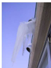
共用片廊下の排気ダクトから結露が流れ出てきた氷柱
