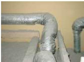
天井断熱上の小屋裏空間に配管された例
