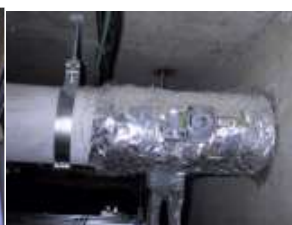
共用片廊下の排気ダクトから結露が流れ出てきた氷柱
