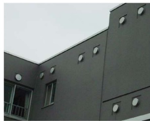
中層住棟の外壁に設けられた防虫網付ペントキャップの目詰まり
