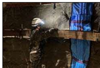
⑤鋼製支保 岩盤の壁面を支え安定性を保つため、立坑と同じ円周形に曲げた鋼製材料を壁面に取り付けます。
