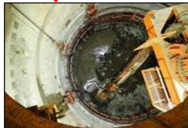
②掘削 ブレイカーで岩盤を砕きます。
