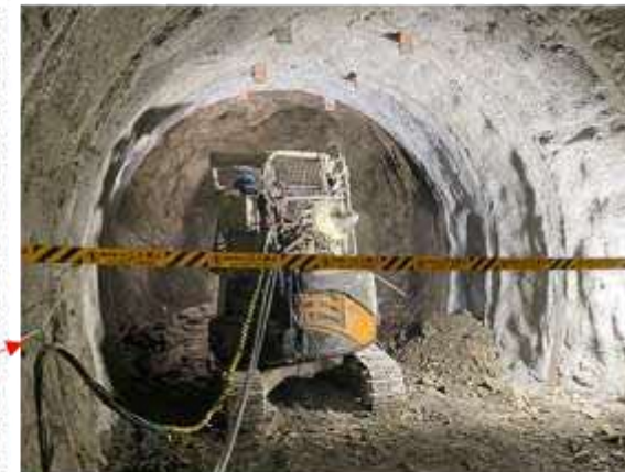
試験坑道7の掘削の様子
