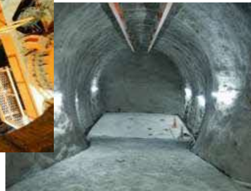
東立坑側第1ボーリング横坑
