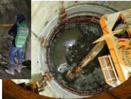
東立坑掘削状況
