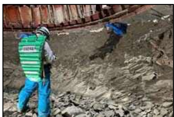
④壁面観察 立坑掘削後、岩盤壁面の割れ目分布や湧水の有無などの情報を取得します。
