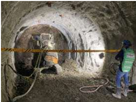
試験坑道7掘削状況
