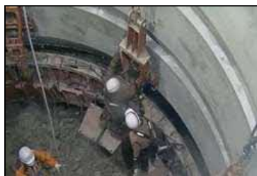
⑦型枠セット 掘削区間にコンクリートを打設するために、立坑と同じ円周形に曲げた型枠を設置します。
