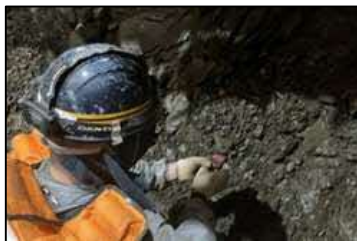
①ガスチェック メタンガスの有無を確認します。
