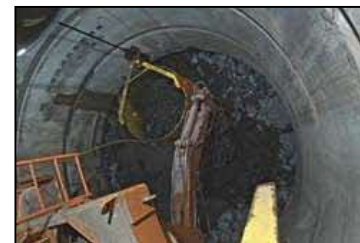
③掘削土（ズリ）出し 砕いた掘削土（ズリ）をかご（キブル）に積込んで地上に搬出します。
