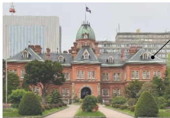
工事前の赤れんが庁舎
