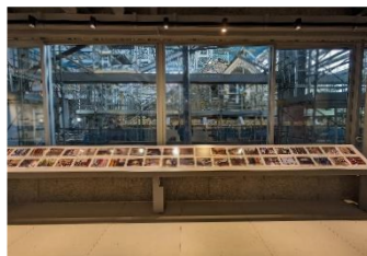
施設内から窓越しに 改修工事が見学可能
