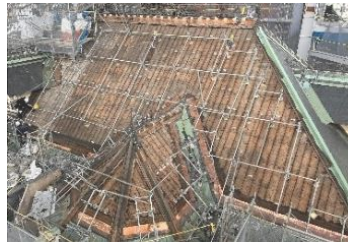
スレート取り外し後
