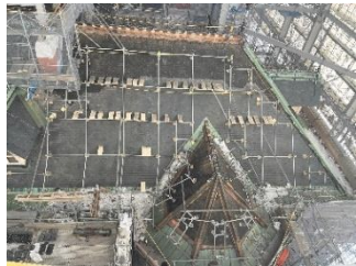
スレート取り外し前
