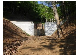
流木捕捉式治山ダム
