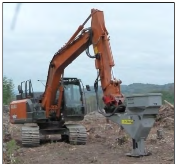
(機械によるコンテナ苗植栽)
